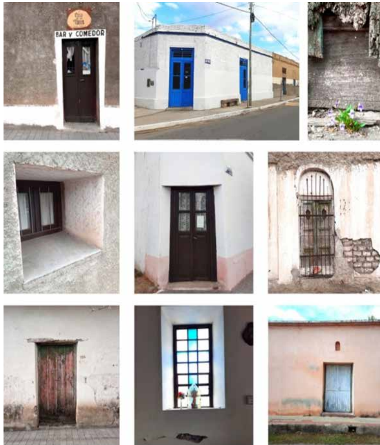
Imagen 18 – Aberturas antiguas. Fuente: composición fotográfica propia.
