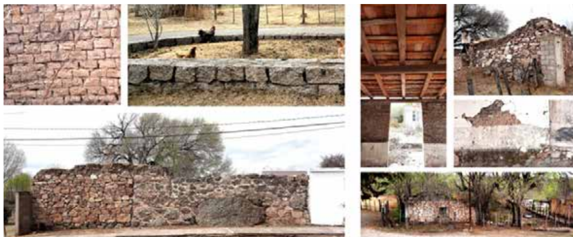
Imagen 16 – Tecnología de piedra apilada – Fuente: composición fotográfica propia.
